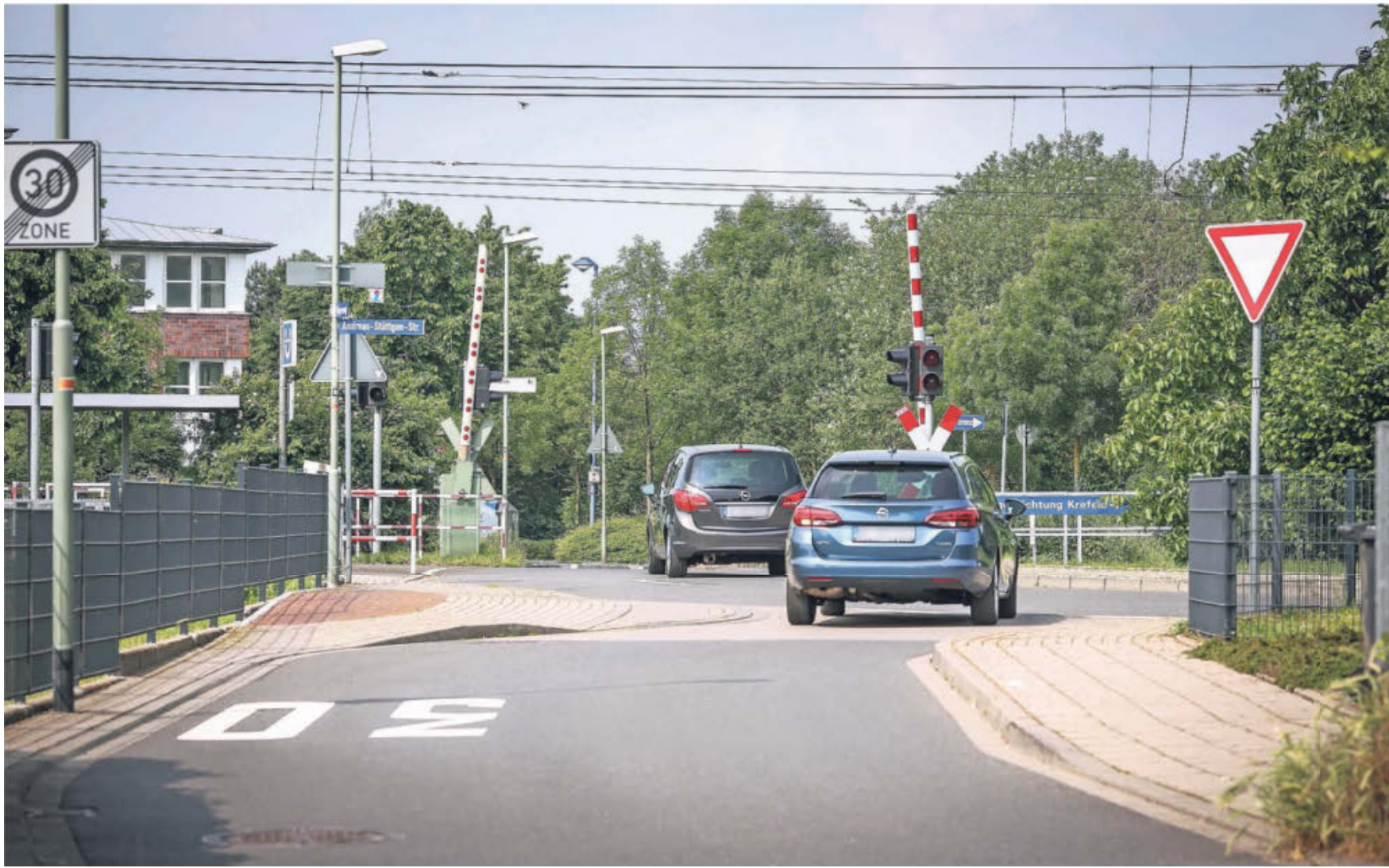
Die Fahrbahn des Meyerswegs soll zwischen Bahnübergang Görgesheide und Mollsfeld auf 5,50 Meter erweitert werden.
